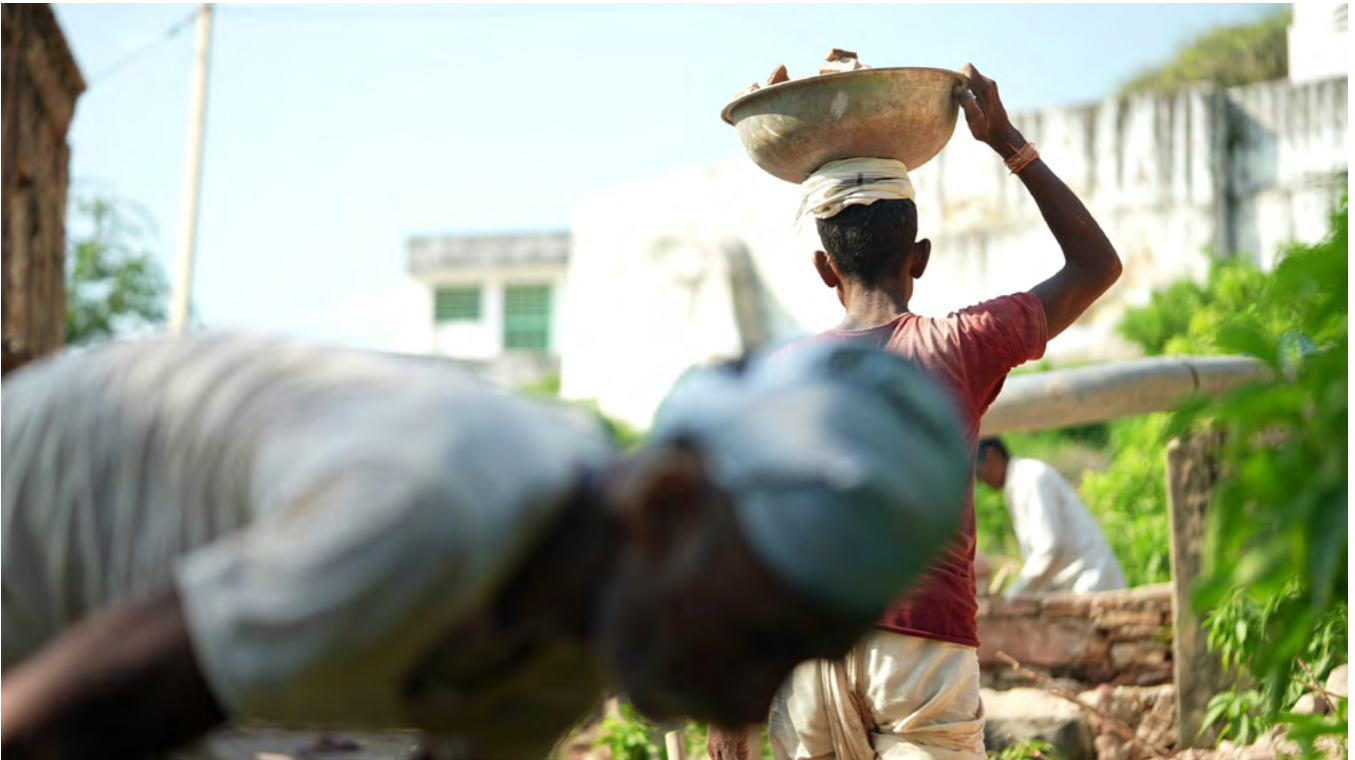
Viele junge Adivasi-/Dalit-Migrant:innen arbeiten als Gelegenheitsarbeiter:innen im Bausektor.
